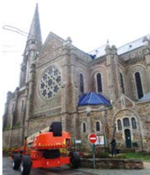
L'église en cours de bâchage
