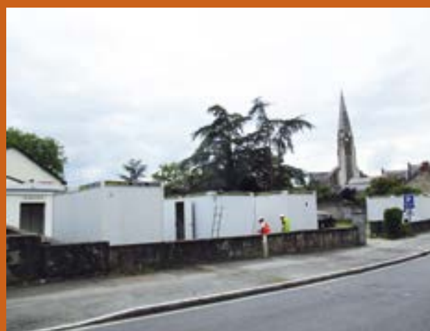
Les bungalows le long de la route de Fay-de-Bretagne.
