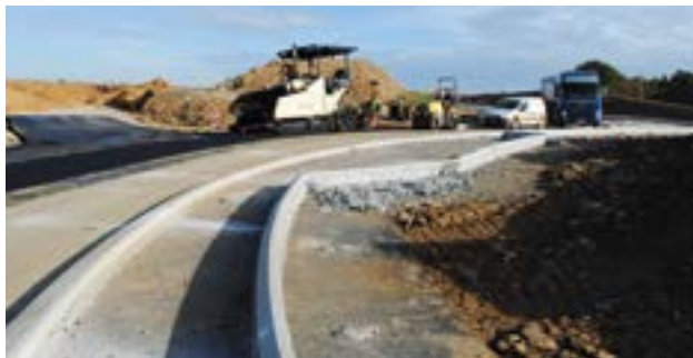
Travaux route de Fay-de-Bretagne - Novembre 2017.
