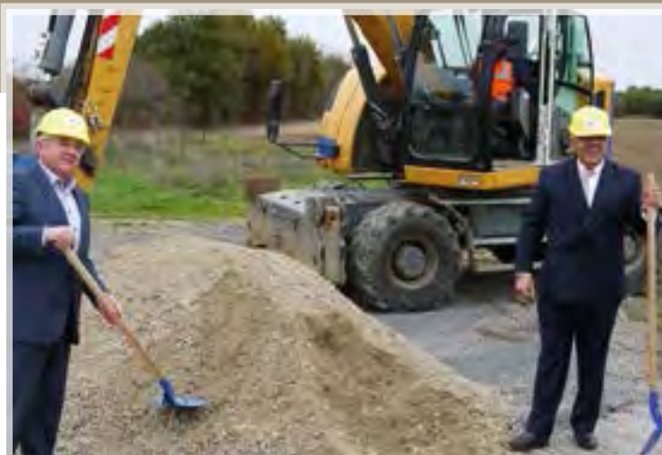
Lancement des travaux de la déviation - 15 novembre 2017 Marcel Verger et Mohamed Saadallah sous-préfet de Chateaubriant-Ancenis
