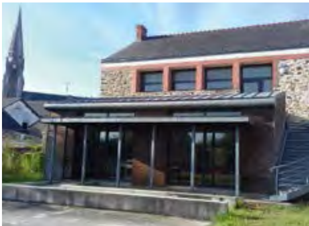
La nouvelle entrée du Tiers-Lieu par la Minoterie
