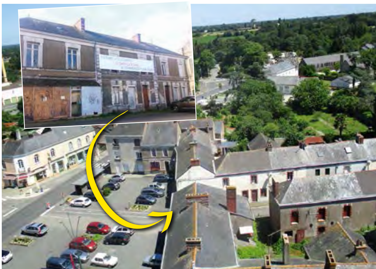
L'immeuble Datin place de l'Abbé-Corbillé en premier plan doit être démoli
