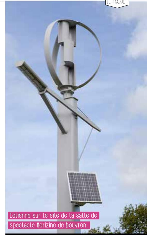
Eolienne sur le site de la salle de spectacle Horizinc de Bouvron.
