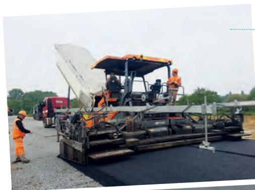
Mise en œuvre de la grave-bitume.
