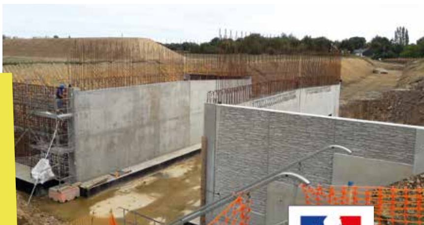
Parement "imitation pierre" de l'ouvrage d'art du Chatel
