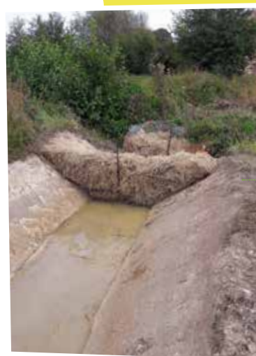
Déviation du ruisseau de la Farinelais - Filtre à paille servant à filtrer les eaux pompées dans le ruisseau après la pêche de sauvegarde.
