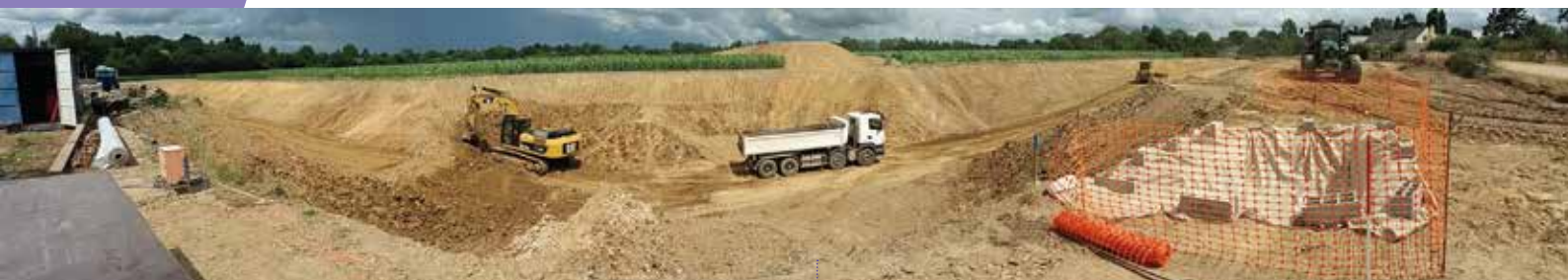
Terrassements au Chatel - juin 2017
