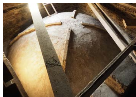
Vue des dômes sous charpente
