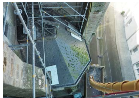
Vue en descente de l'échafaudage
