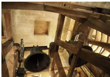
Cloches et trappe d'accès à la flèche
