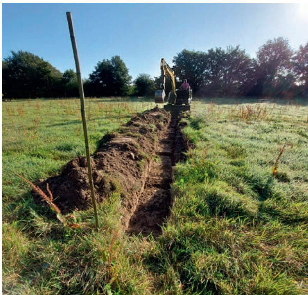
Réalisation d'un fossé, permettant la formation d'un talus exposé au sud
