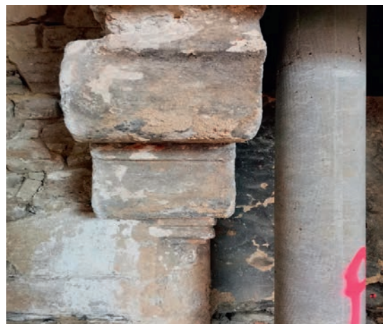
Appui de cheminée
